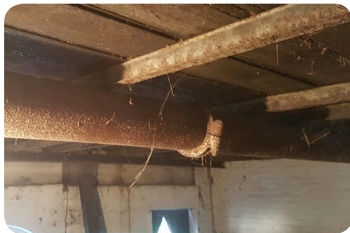
Restanten van de pijpleiding hergebruikt in Ottersum
